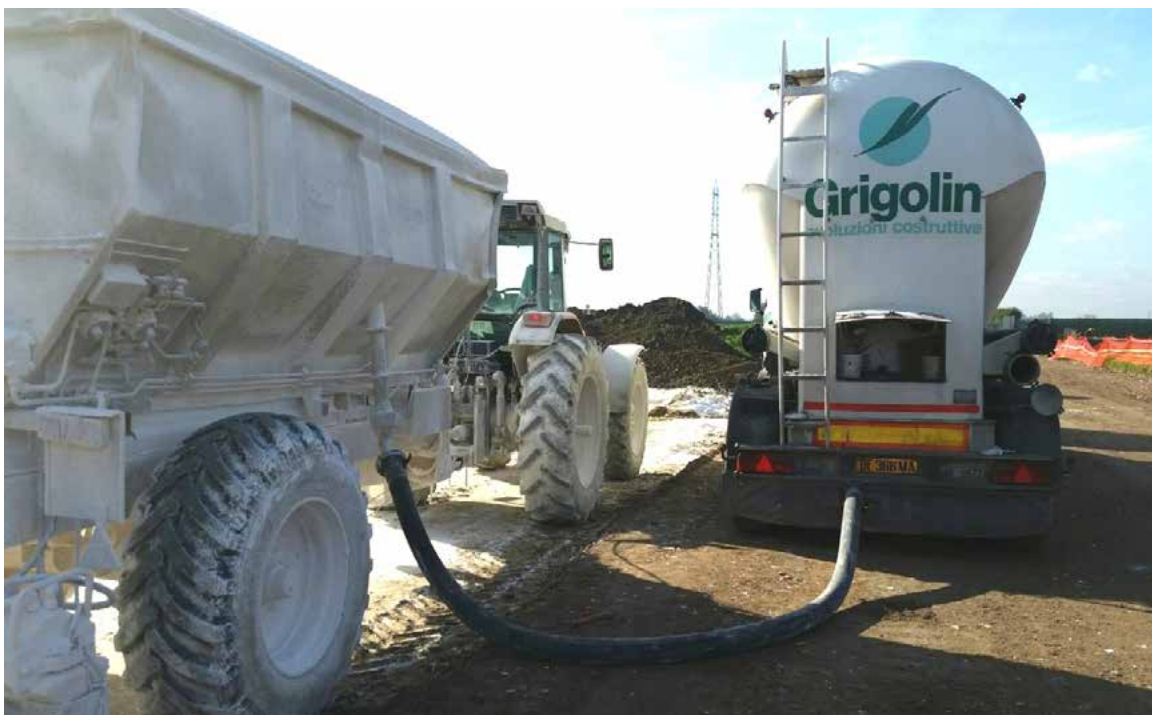
fornitura materiale sfuso con spandicalce per stabilizzare il terreno - ossido di calce ad alta reattività
