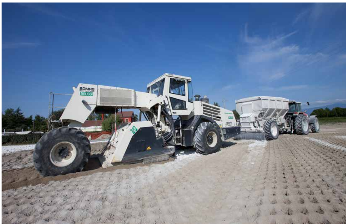
mezzi in opera per stabilizzare il terreno
