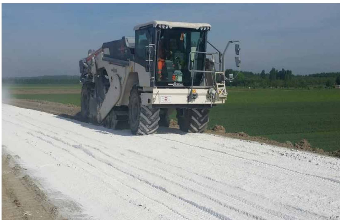
stabilizzazione a calce con pulvimixer
