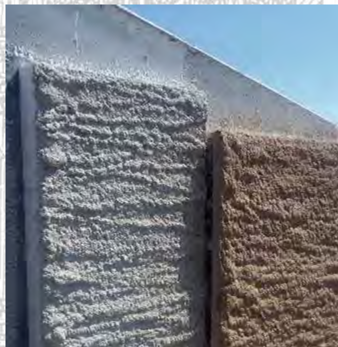
Campionature di intonaco eseguite in cantiere
