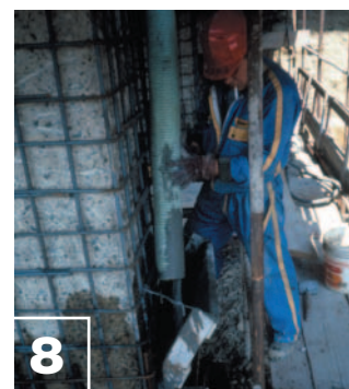
Fig. 8 Getto entro cassero di una malta colabile (da "Il Calcestruzzo Vulnerabile: Prevenzione, Diagnosi del Degrado e Restauro", Ed. Tintoretto, Villorba 2004).
